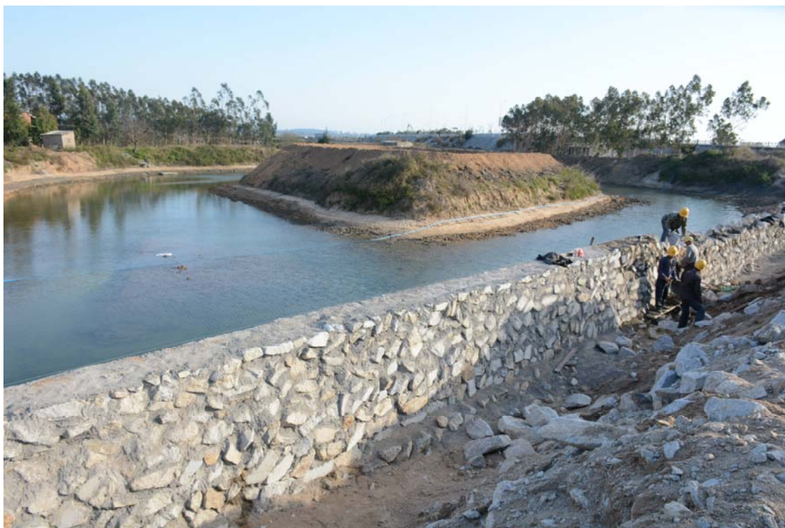
照片 11 港塔溪施工便道挡墙施工
