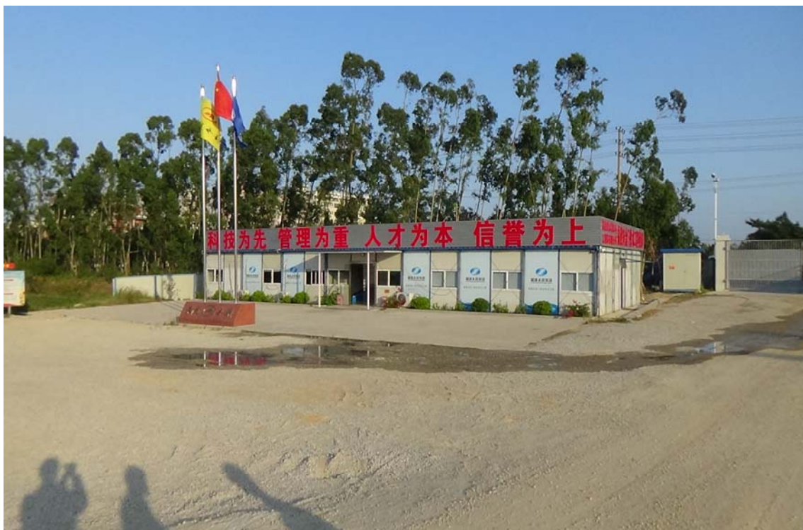
照片 33 施工生产生活区施工期
