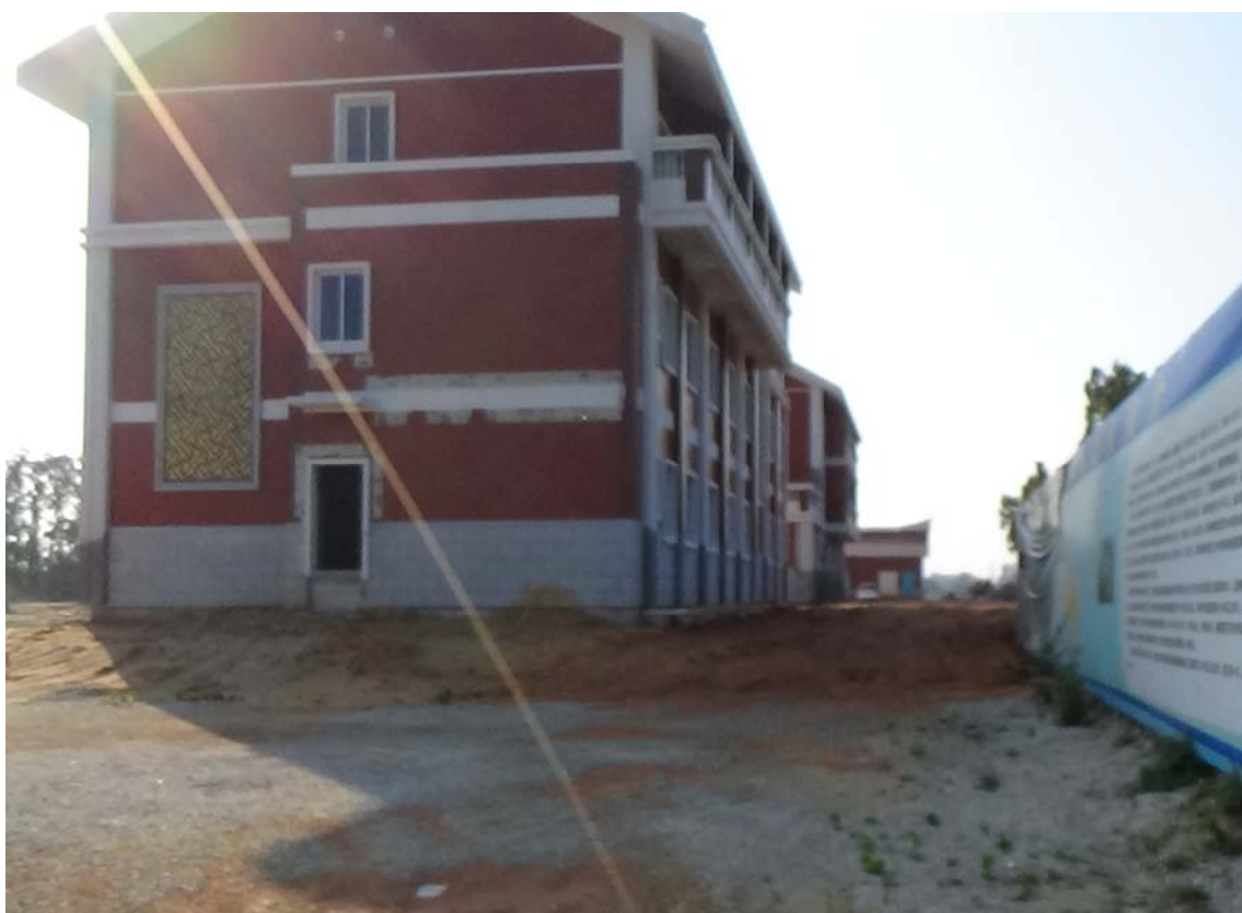
照片 17 泵站施工中尚未绿化
