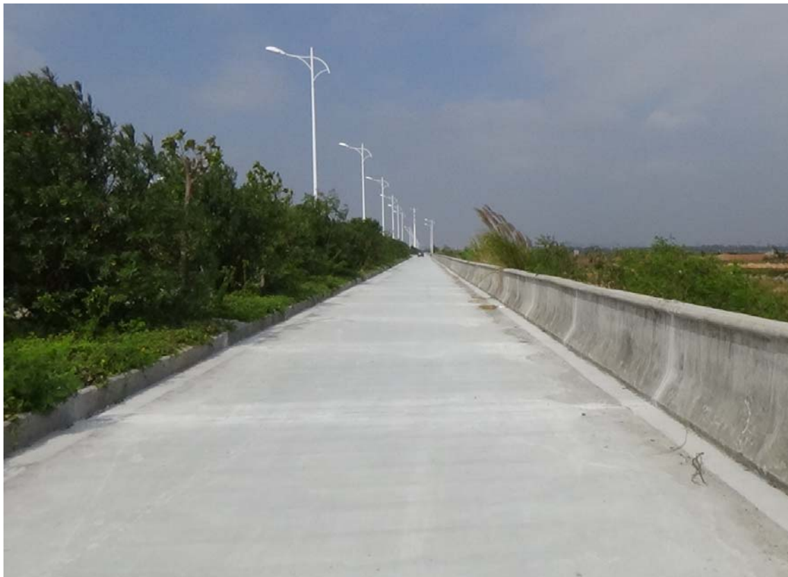
附件 6 管线施工结束后
