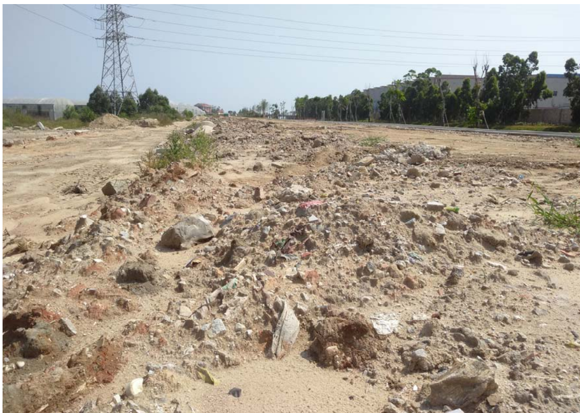
照片 2：港塔溪段清淤工程后，目前建设单位已与福建东甲建设有限公司签订施工合同
