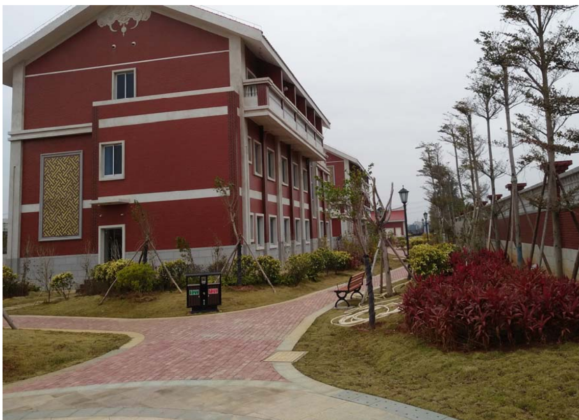
照片 18 泵站施工结束后绿化
