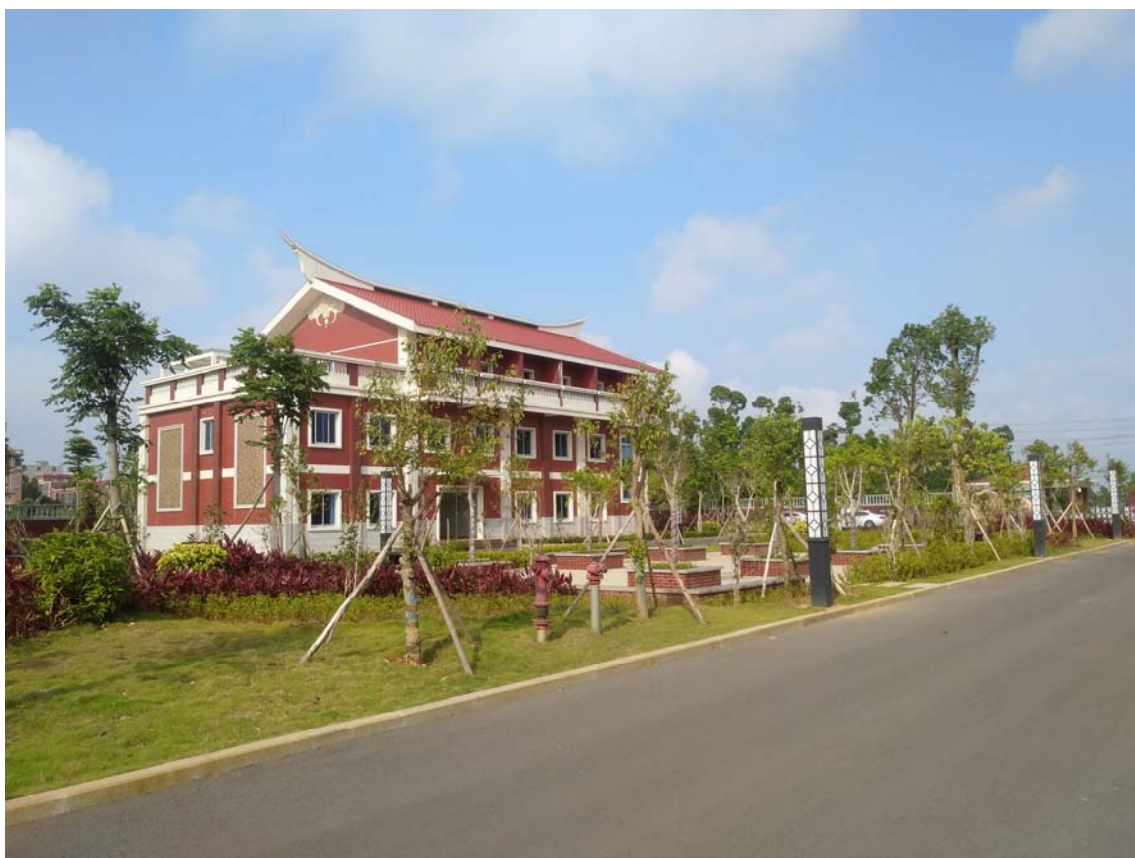
照片 10 泵站区施工结束
