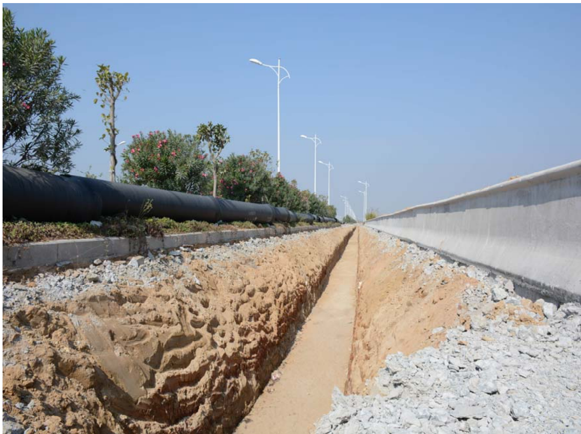
照片 5：管线区施工中
