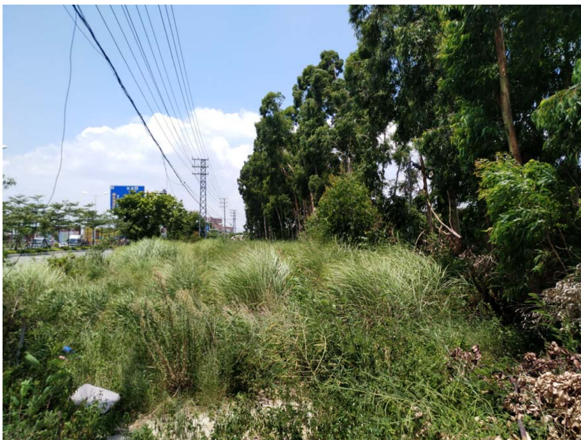
照片 25 主体供水管线区植被恢复现状
