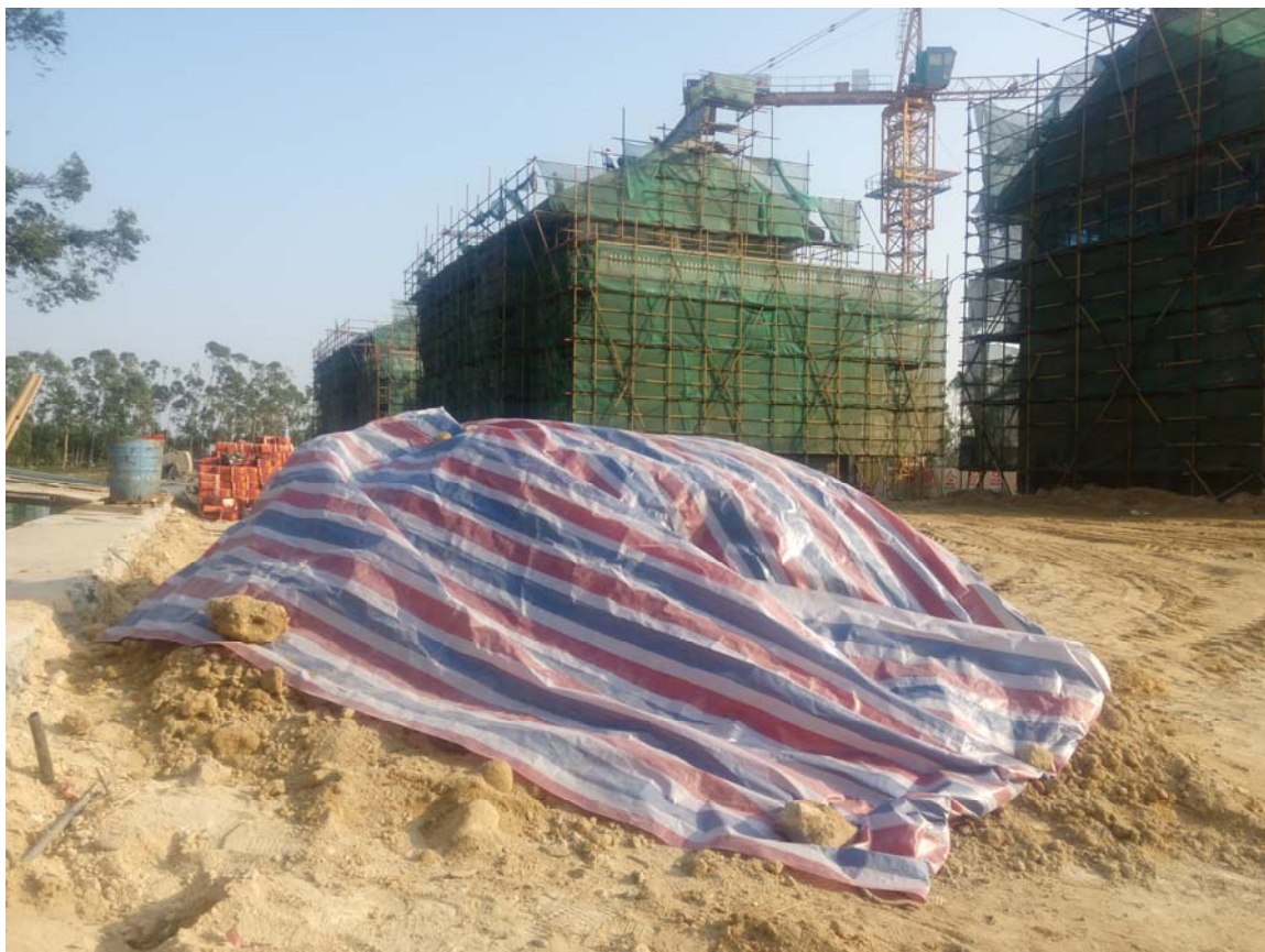
照片 19：泵站区临时土方采用彩条布覆盖
