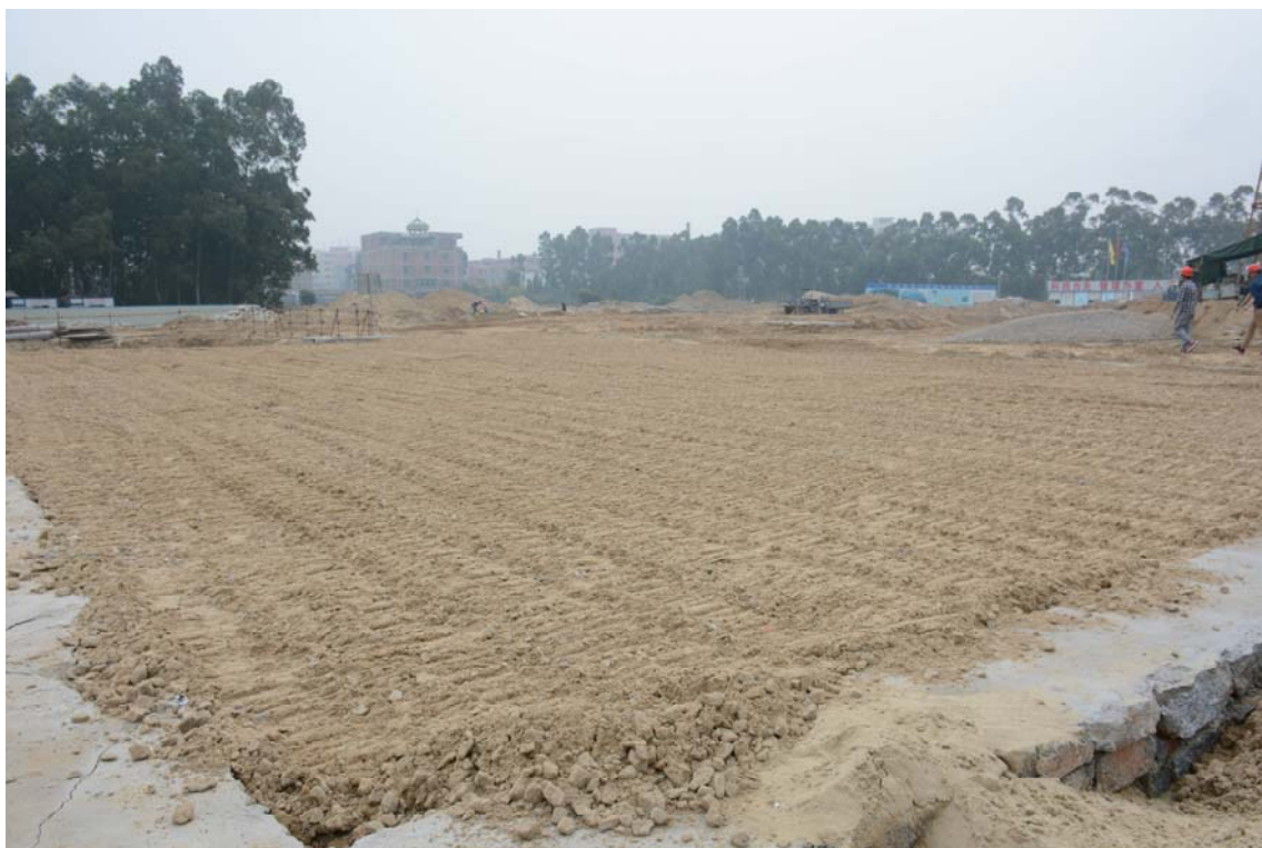
照片 9 泵站区施工初期
