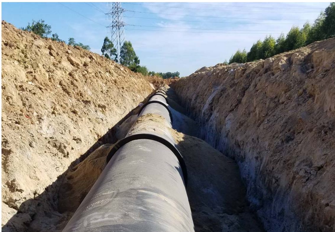
照片 1：港塔溪段主体管线工程施工中
