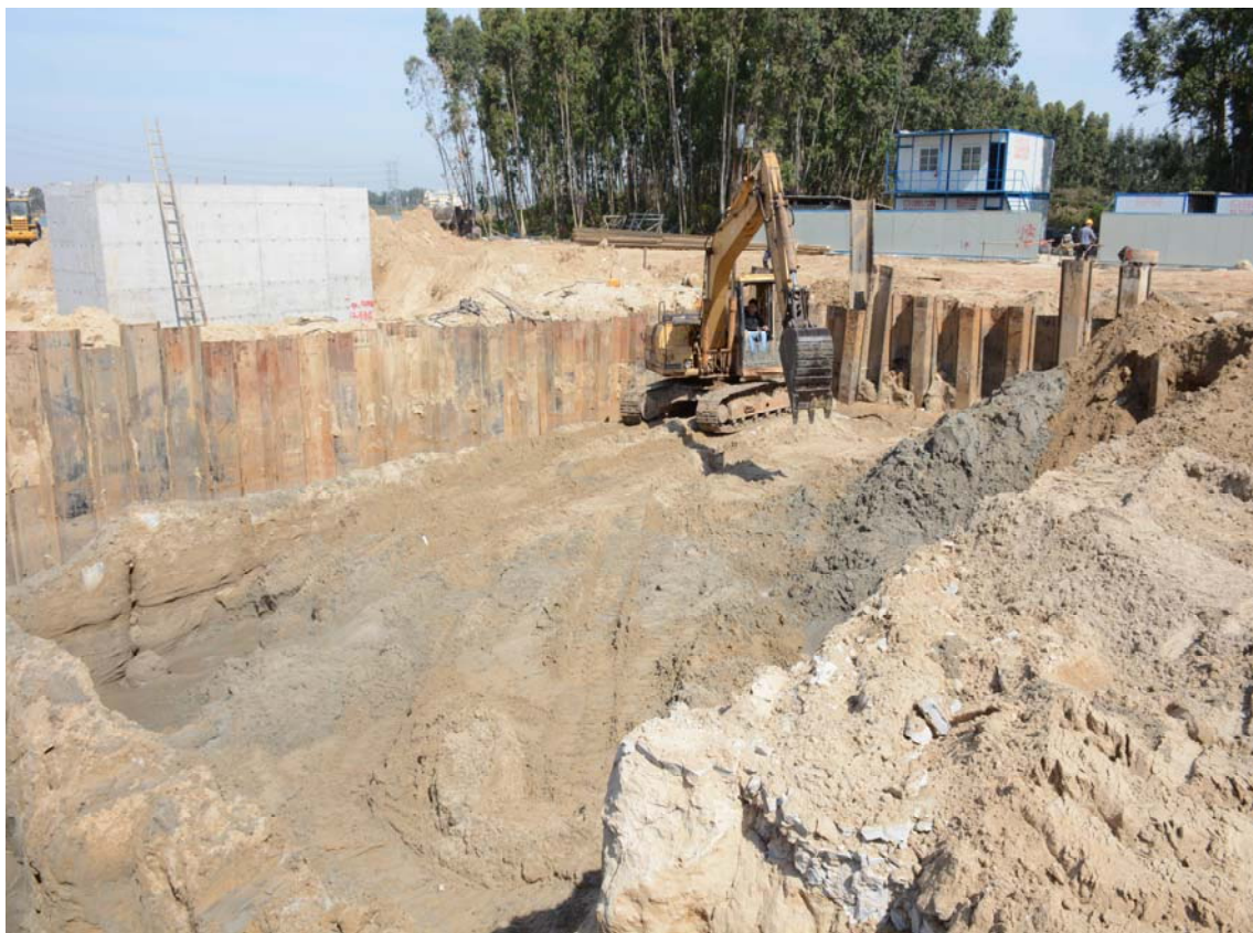
照片 7 泵站区施工中（钢板桩）
