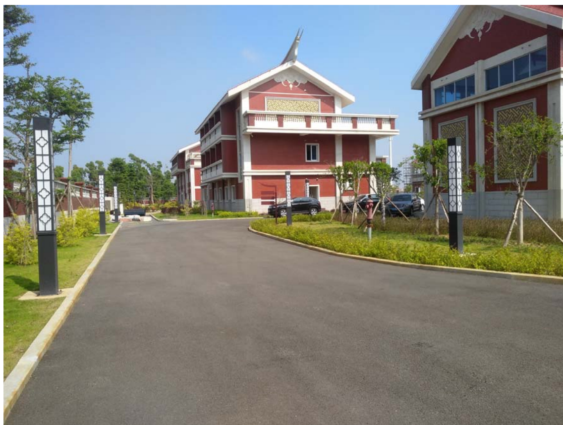
照片 20：土方回填后场地硬化及绿化
