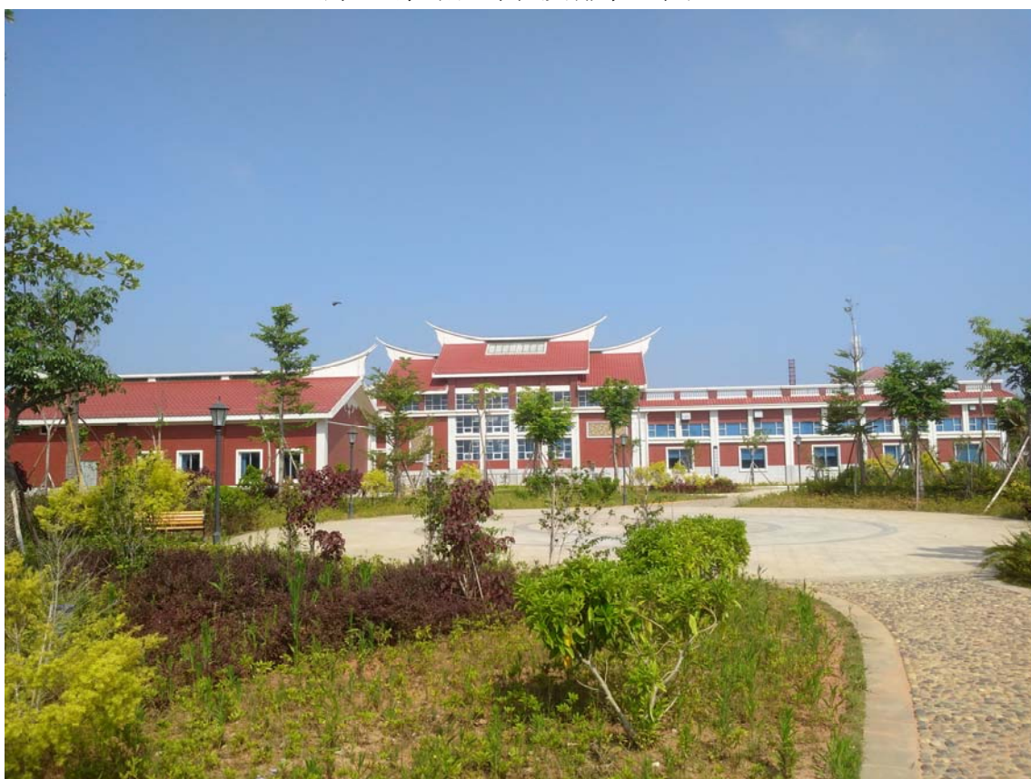
照片 32 泵站区绿化及排水工程施工结束后
