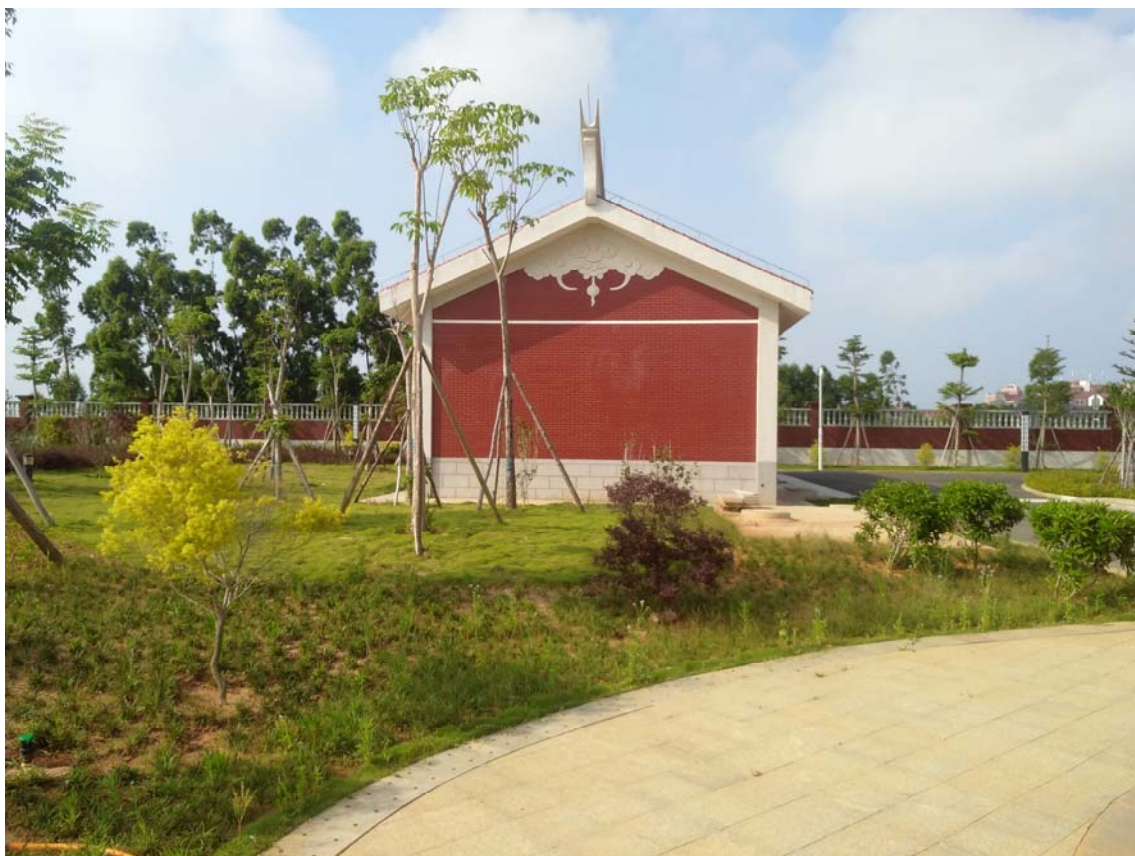
照片 8 泵站区施工结束
