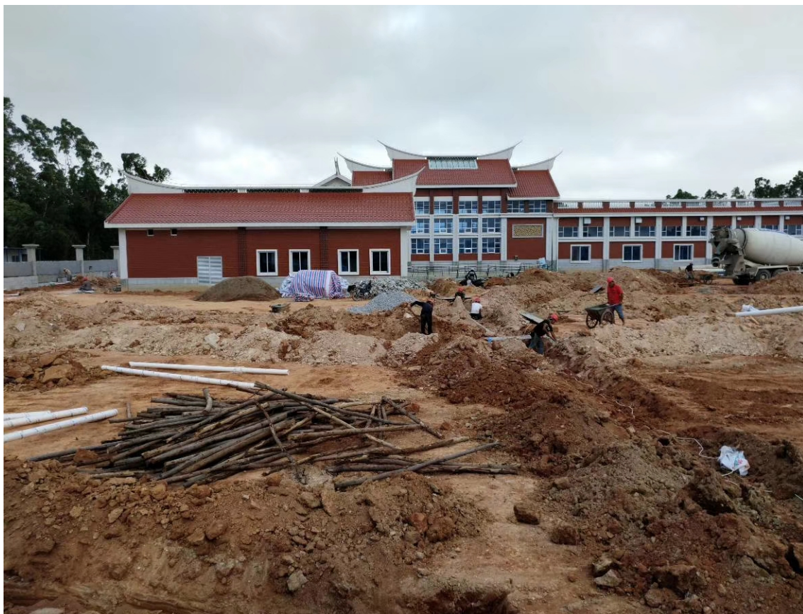
照片 31 泵站区绿化及排水工程施工
