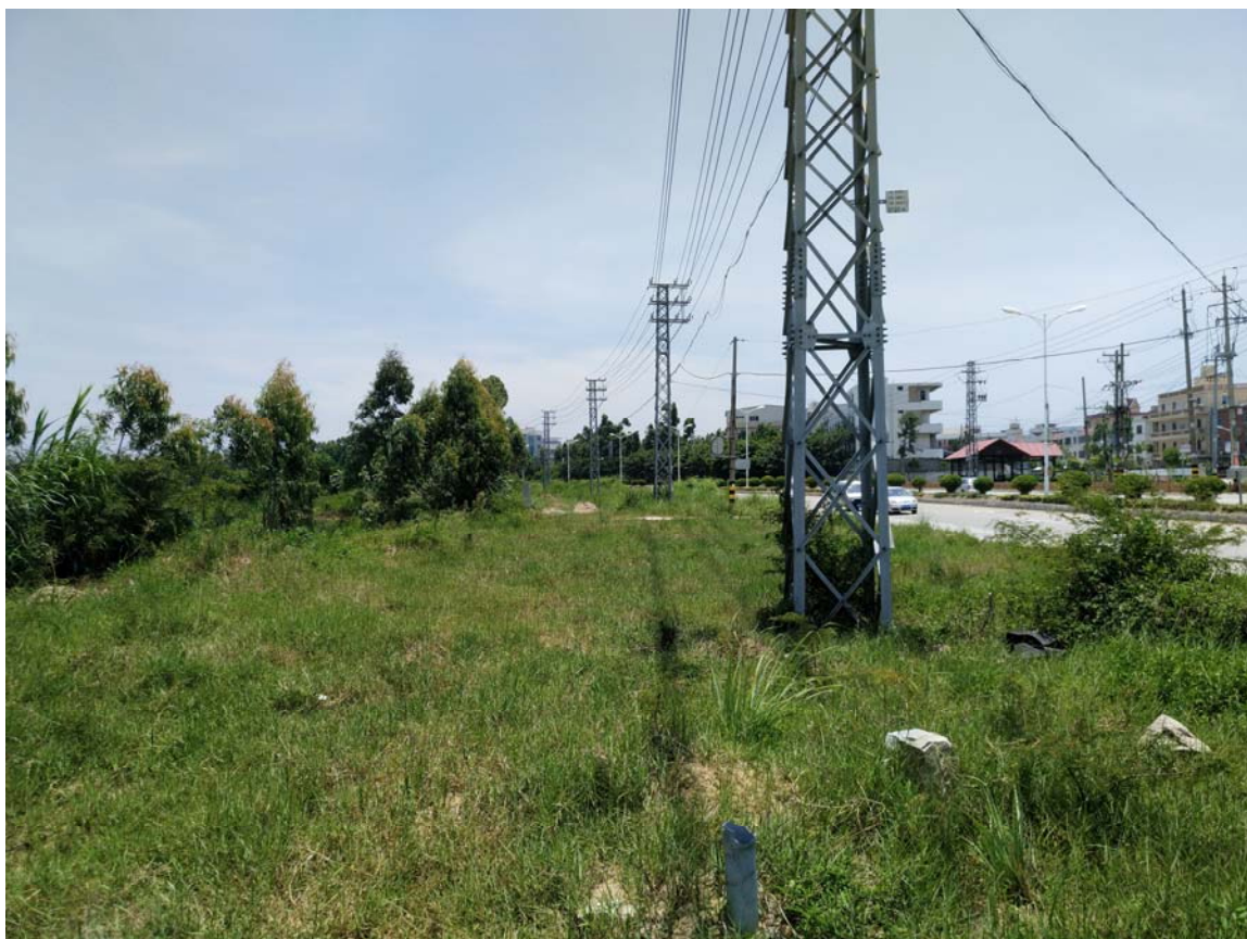
照片 29 主体供水管线区施工结束后撒播草籽绿化
