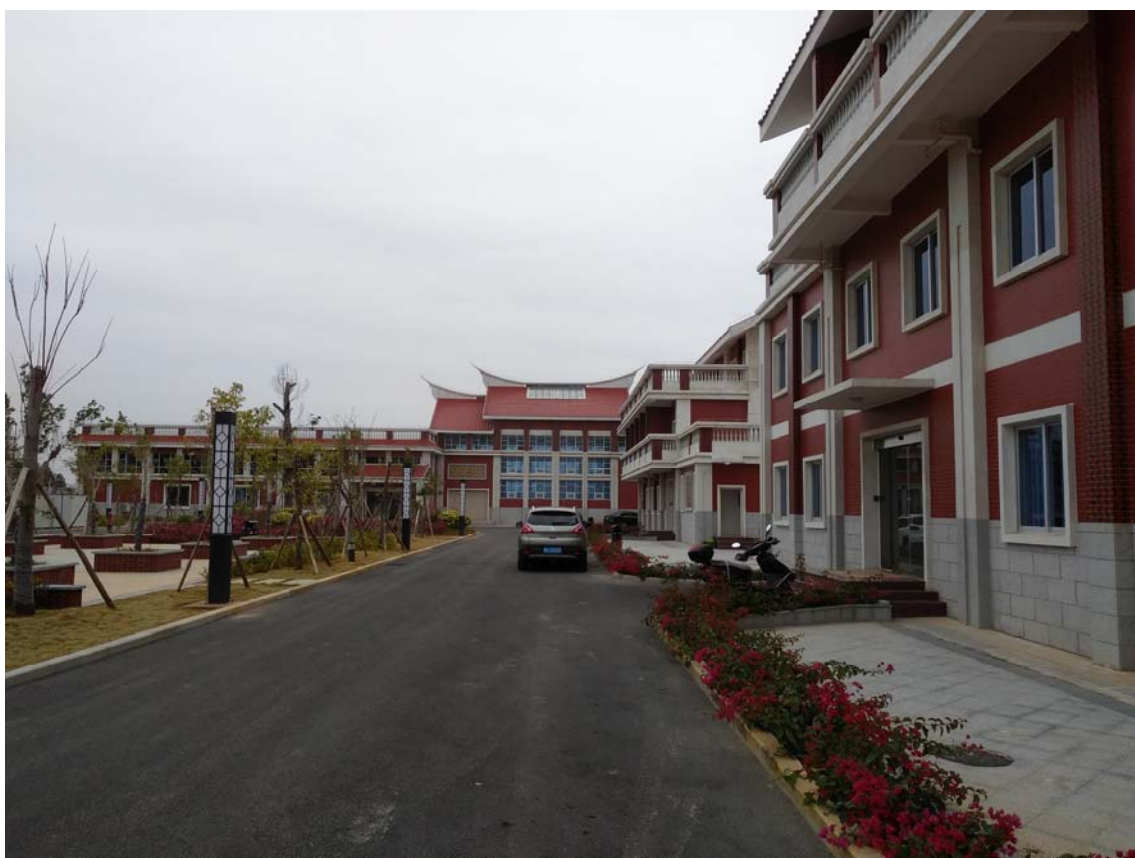
照片 16 泵站施工结束
