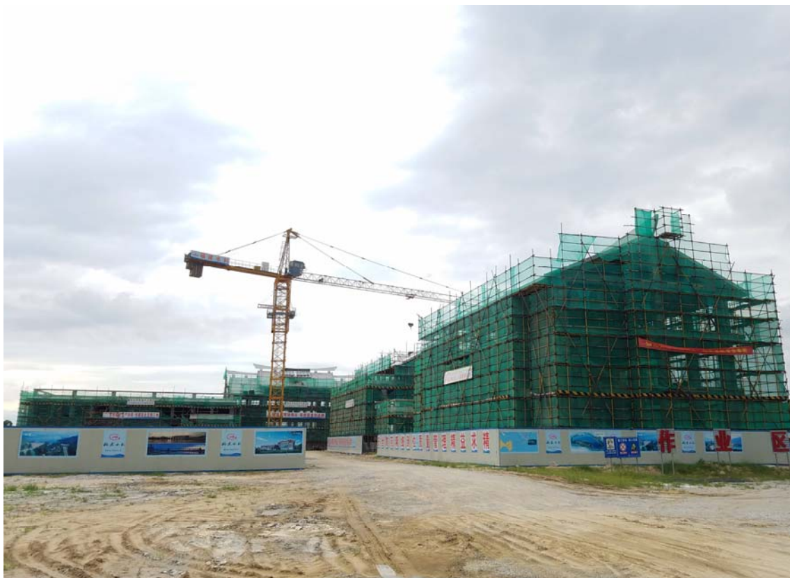
照片 3：泵站区施工中
