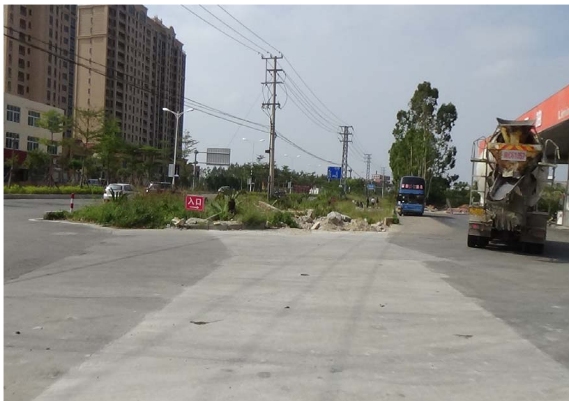
照片 24 主体供水管线区破路后恢复路面
