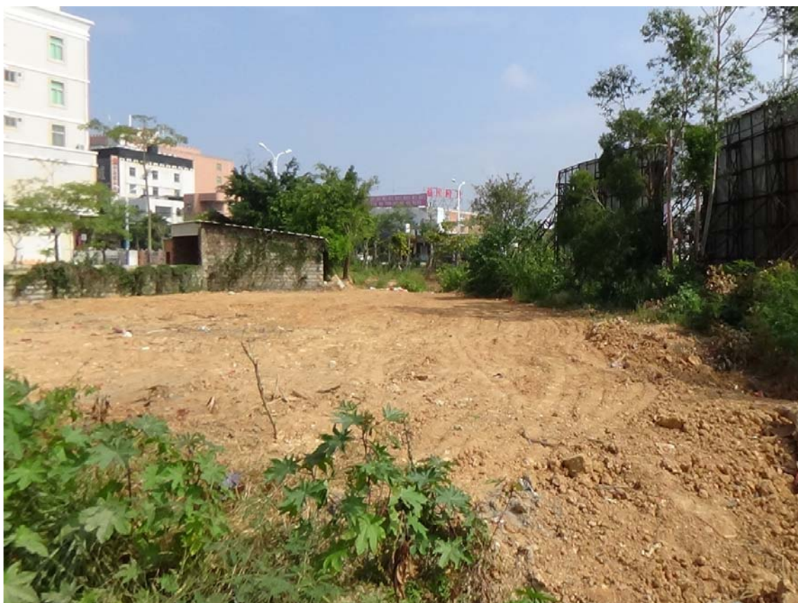
照片 13 管线施工结束后尚未绿化
