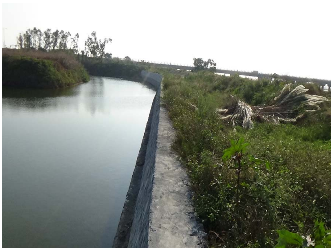
照片 26 港塔溪段施工便道挡墙及绿化现状
