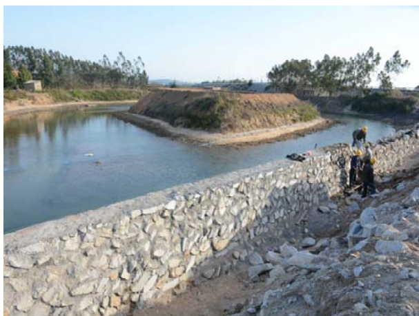
港塔溪段施工便道挡墙施工
