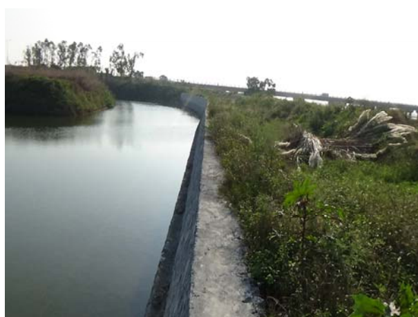
港塔溪段施工便道挡墙施工结束绿化
