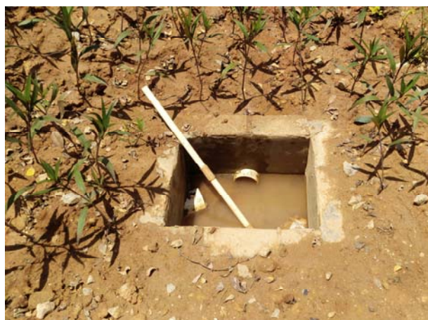
泵站区雨水管线、沉沙池及绿化
